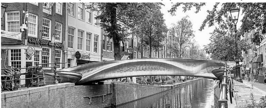
Длина моста составляет 12,2 м, ширина — 6,3 м. Для создания его сложной структуры были задействованы четыре робота, сваривающие слои горячего металла вместе с использованием стандартной сварочной проволоки и газа. Всего было использовано 6000 кг нержавеющей стали.
