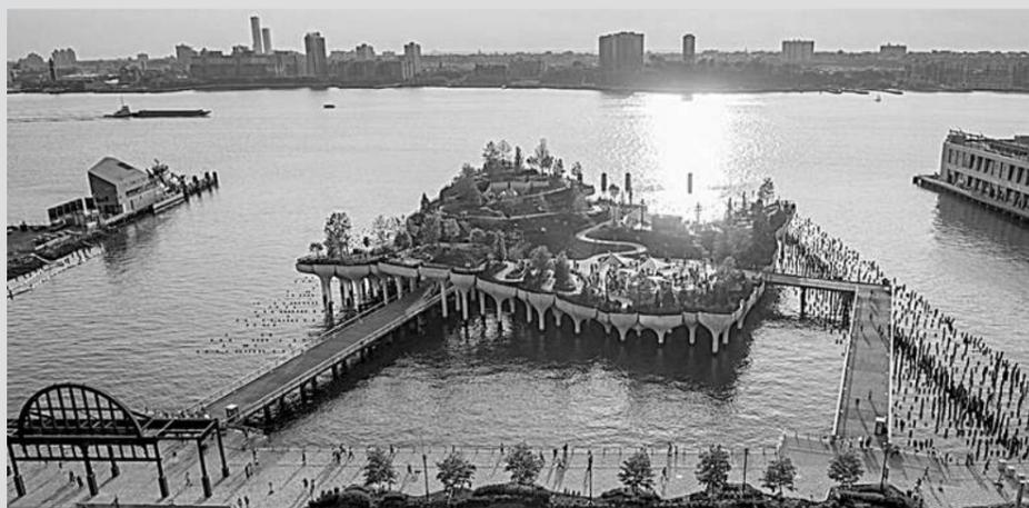
нолитная бетонная плита соединяет все сборные элементы. Вершины свай представляют собой сборные «лепестки», которые образуют контейнеры шириной шесть метров, заполненные грунтом.
